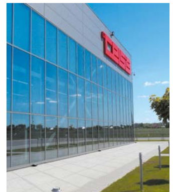
Centrale de la société Celsis Lituanie
